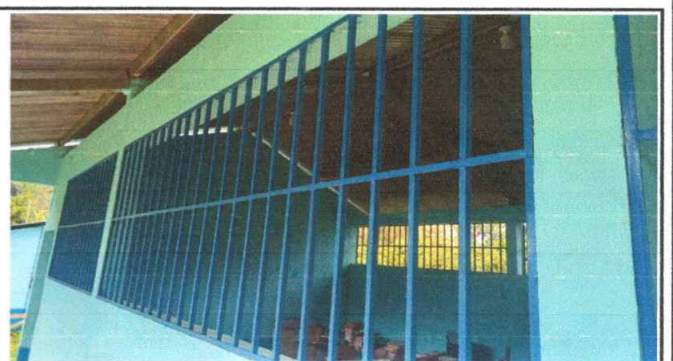
Foto 6: Mantenimiento de barandas
