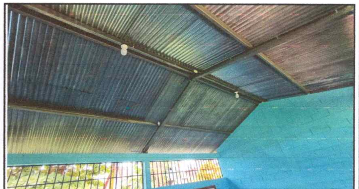
Foto 4: Sustitucion e instalacion de sistema electrico
