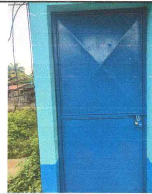
Foto 2: Reparacion de puertas
