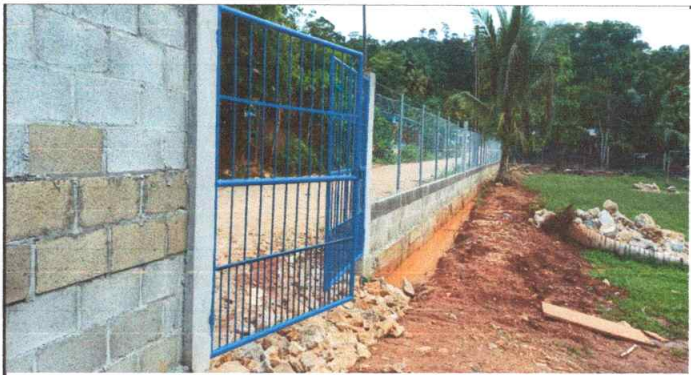
Foto 3: Reparacion y mejoramiento de muro perimetral
