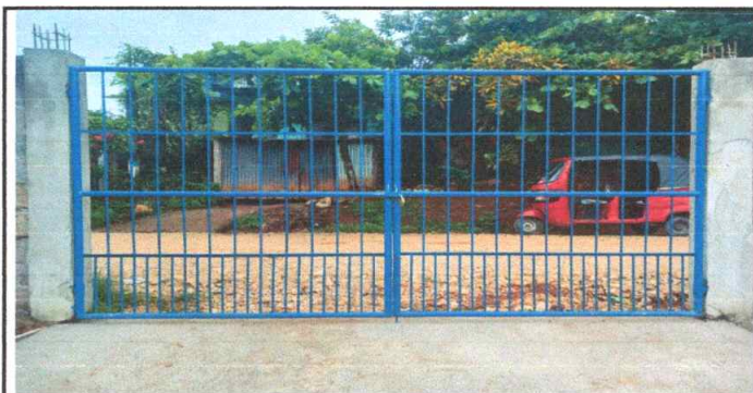
Foto 5: Cambio de porton de madera por uno de metal
