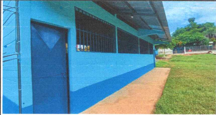
Foto1: Trabajo de pintura interior y exterior
